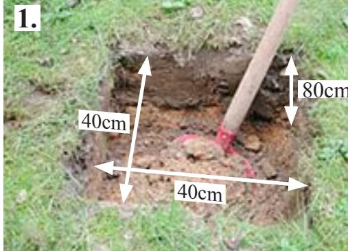
Eine Grube für jeden Pfosten ausheben.
