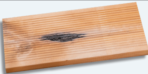
Bretter mit Fäulnis und faulen Ästen
