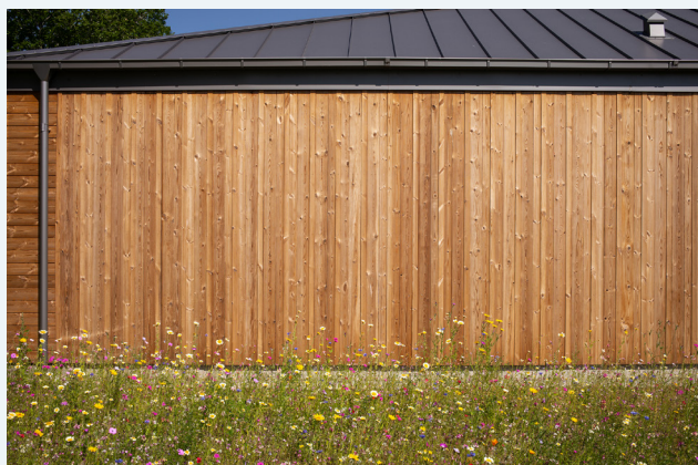
Frisch montierte Fassade
