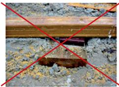
Die Unterkonstruktion nicht einbetonieren!
