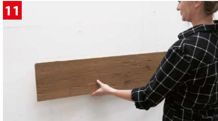
11 Nach dem Auftragen von Montagekleber und dem Anbringen der Pads. HQ DekoWall ausrichten und andrücken, bis die Klebepads greifen.
