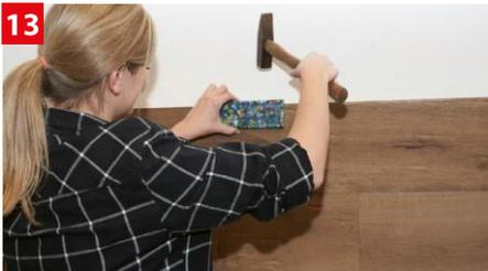
13 Erst die Fugen schließen, eventuell mit leichten Schlägen gegen das Klopffholz auf die Feder, dann die Diele fest an die Wand drücken, bis die Klebepads greifen.
