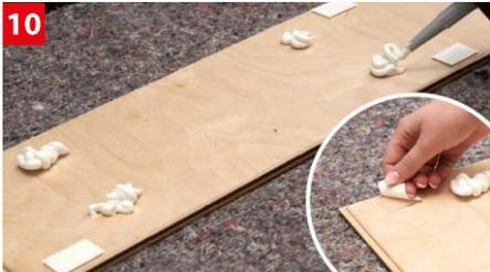
10 Klebepad+Kleber entlang der Federkante in einer Reihe mit einem Abstand von 30 – 40 cm anbringen. Bei der untersten Dielen auch eine 2. Reihe entlang der Nut wie auf dem Bild gezeigt wird. Vor der Montage Schutzpapier entfernen, Klebefläche nicht berühren (klebt nur 1x)!
