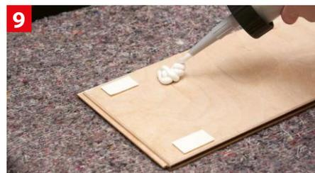
**9** Schutzpapier des Klebepads auf einer Seite entfernen, das Pad auf die Dielenrückseite kleben und sorgfältig festdrücken. Direkt daneben kommt etwas Montagekleber. Nur bei der ersten Reihe werden Pads und Kleber auf beiden Seiten (Nut und Feder) angebracht. Ab der zweiten Reihe wird nur an der oberen Seite (Feder) Pads und Kleber aufgetragen.
