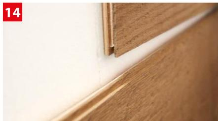
14 Immer mit der Feder nach oben bzw. in Arbeitsrichtung montieren.
