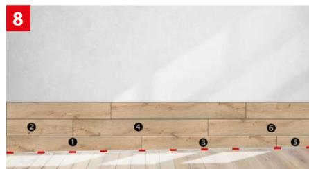
**8** Vorbereiten der Dielen zur Verklebung. Wir empfehlen das Verkleben in folgender Reihenfolge bei den ersten Reihen.
