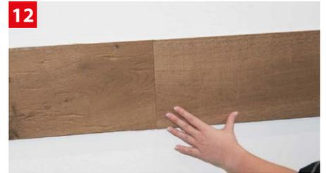
12 Stirnseite passgenau schließen und HQ DekoWall andrücken, bis die Klebepads greifen.
