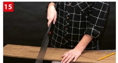
15 Passstücke anzeichnen und mit einer feinen Säge zuschneiden. Das geschnittene Stück sollte nicht kürzer wie 25cm sein.
